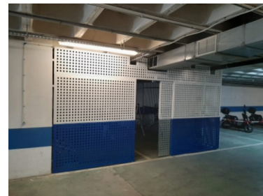
Execució del tancament de l' aparcabicis a J. Gris.
