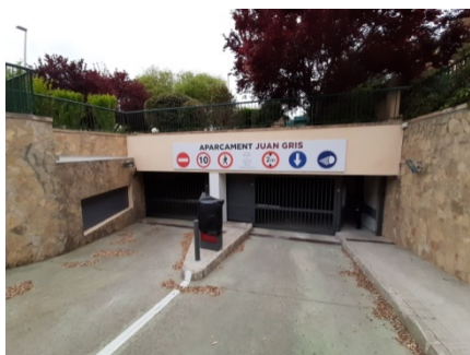
Entrada vehicles a la finalització de les obres.
