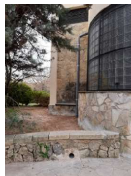
Execució drenatge coberta nucli escales finalitzada.
