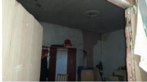
Imagen 4.- Vista de interior del inmueble
