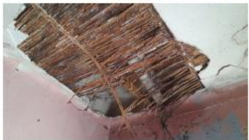
Imagen 7.- Vista de interior del inmueble
