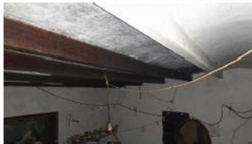
Imagen 6.- Vista de interior del inmueble
