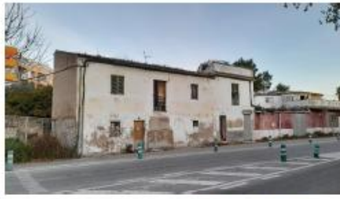
Imagen 2.- Vista de fachada principal
