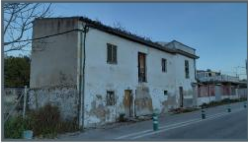
Imagen 1.- Vista de fachada principal
