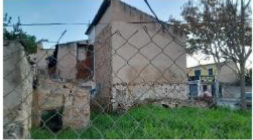
Imagen 3.- Vista de fachada lateral
