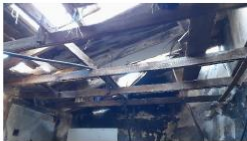
Imagen 8.- Vista de interior del inmueble
