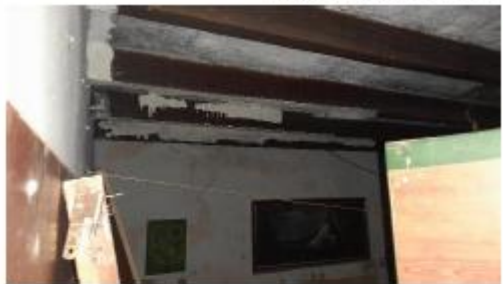
Imagen 5.- Vista de interior del inmueble
