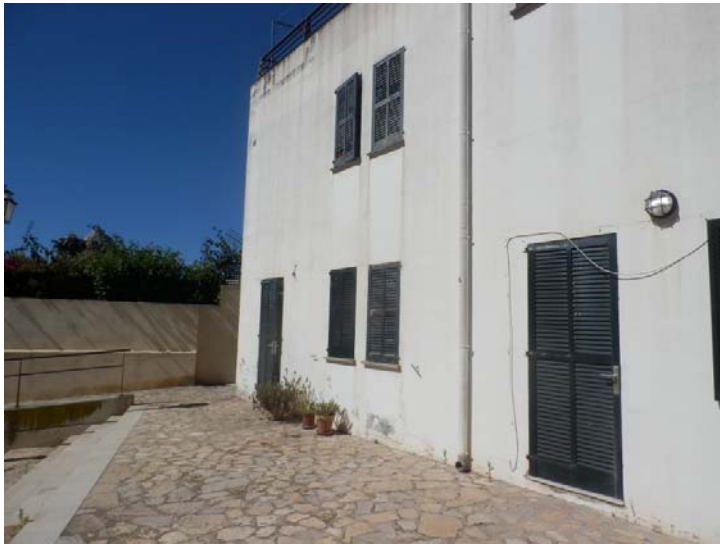
Vista parcial de façana trasera
