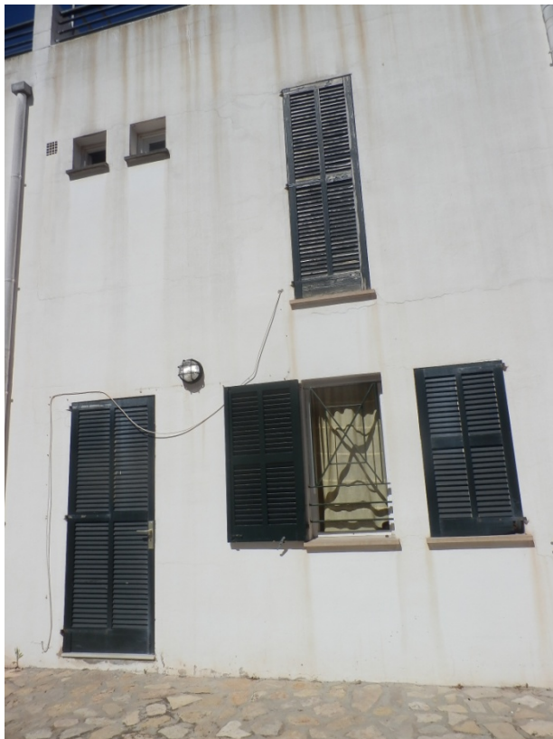
Vista parcial de façana trasera
