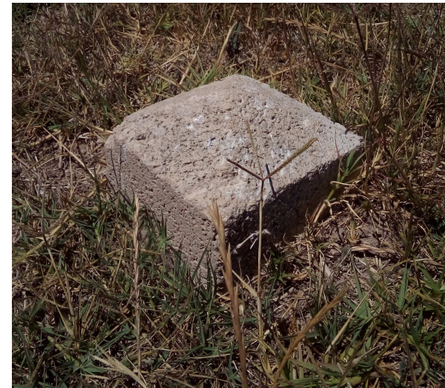
Fites prefabricades de formigó existents de 12x12cm
