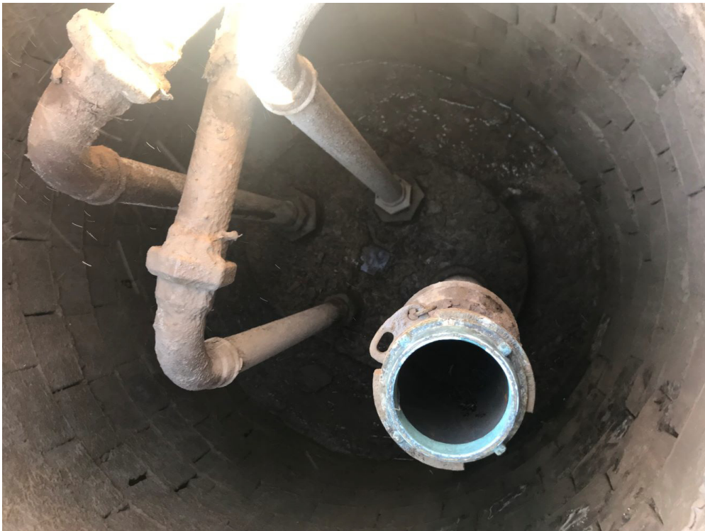
Fotografia 4. Interior de l'arqueta d'accés a les boques del dipòsit 2
