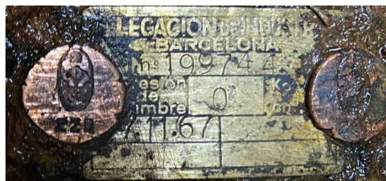
Fotografia 6. Placa de timbrat del dipòsit 1
