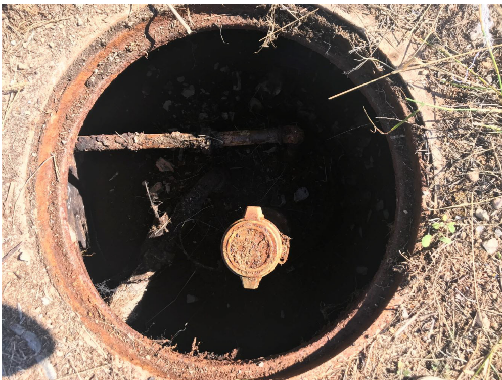
Fotografia 2. Interior de l'arqueta d'accés a les boques del dipòsit 1
