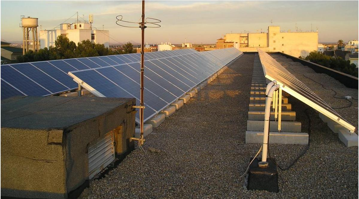
**Imagen:** Ejemplo fragmento de instalación de kit 21 módulos
