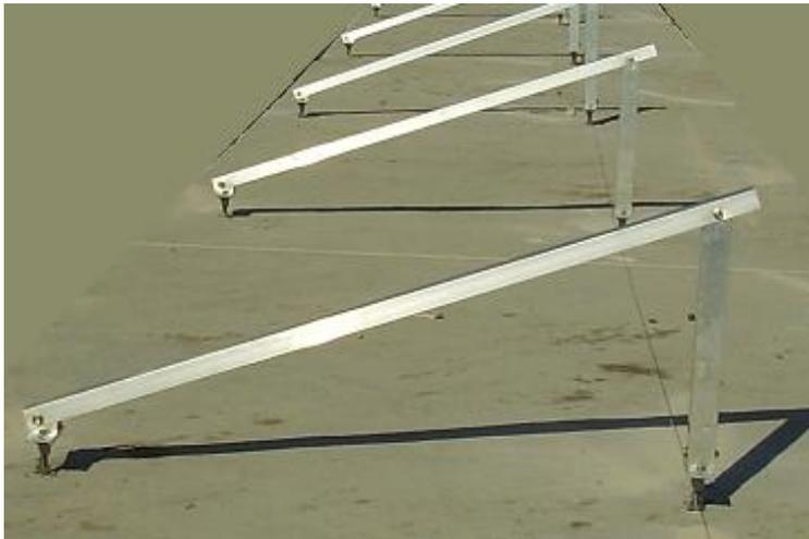
4. Una vez colocado los bastidores proceda a la colocación de los módulos. Empiece por un extremo dejando que el módulo apoye sobre el tope de la placa de dos bastidores consecutivos. Una vez colocado fíjelo con dos Grapas-G7 taladrando por la línea central del bastidor.
