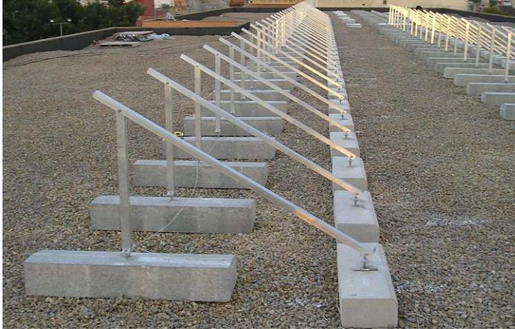
**Imagen:** Ejemplo bastidor sobre cubierta plana de hormigón.
