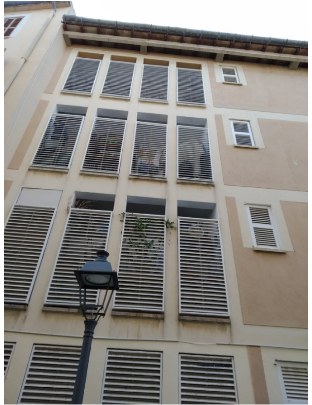
Fachada trasera de la edificación
