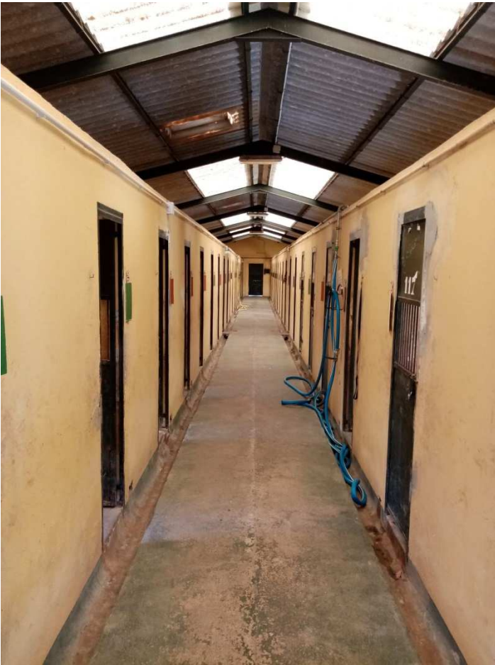
Vista interior del corredor de servei y de la coberta
