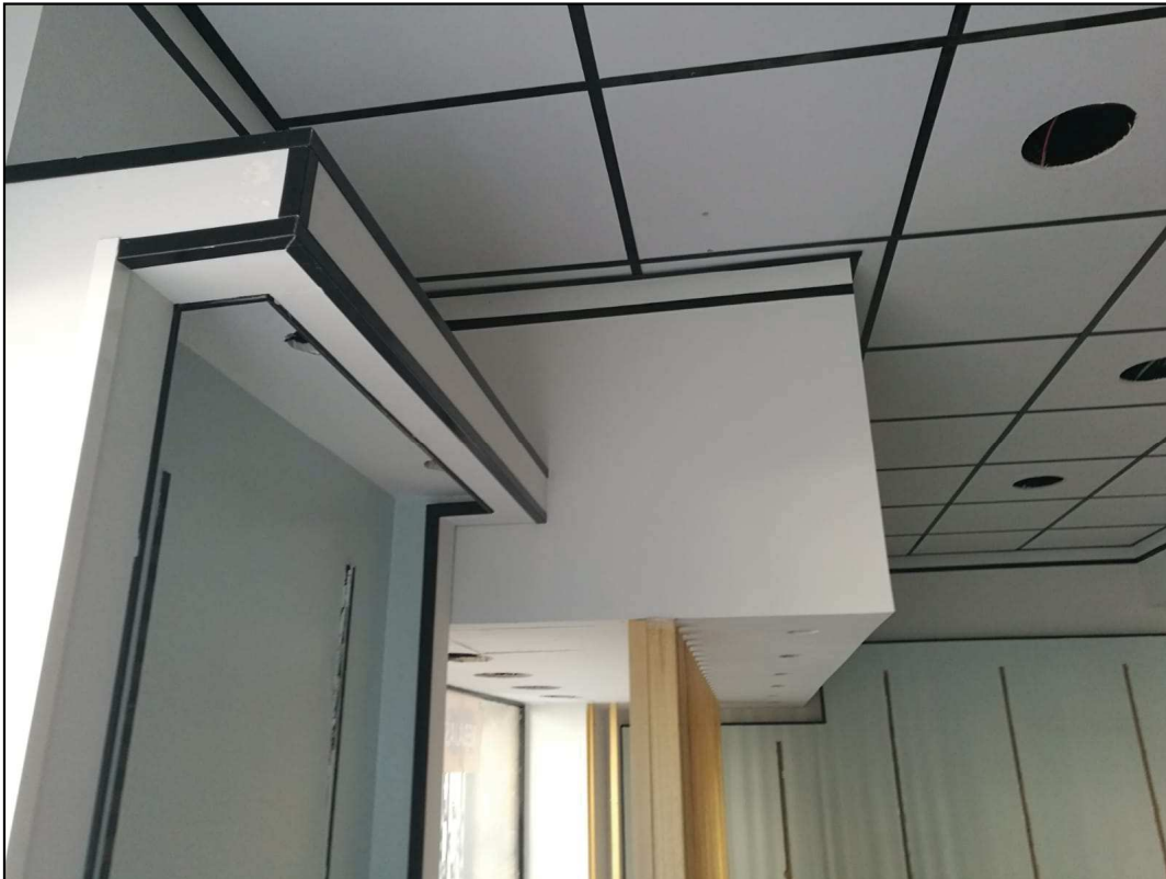
9-Detall de la part interior - mostrador
