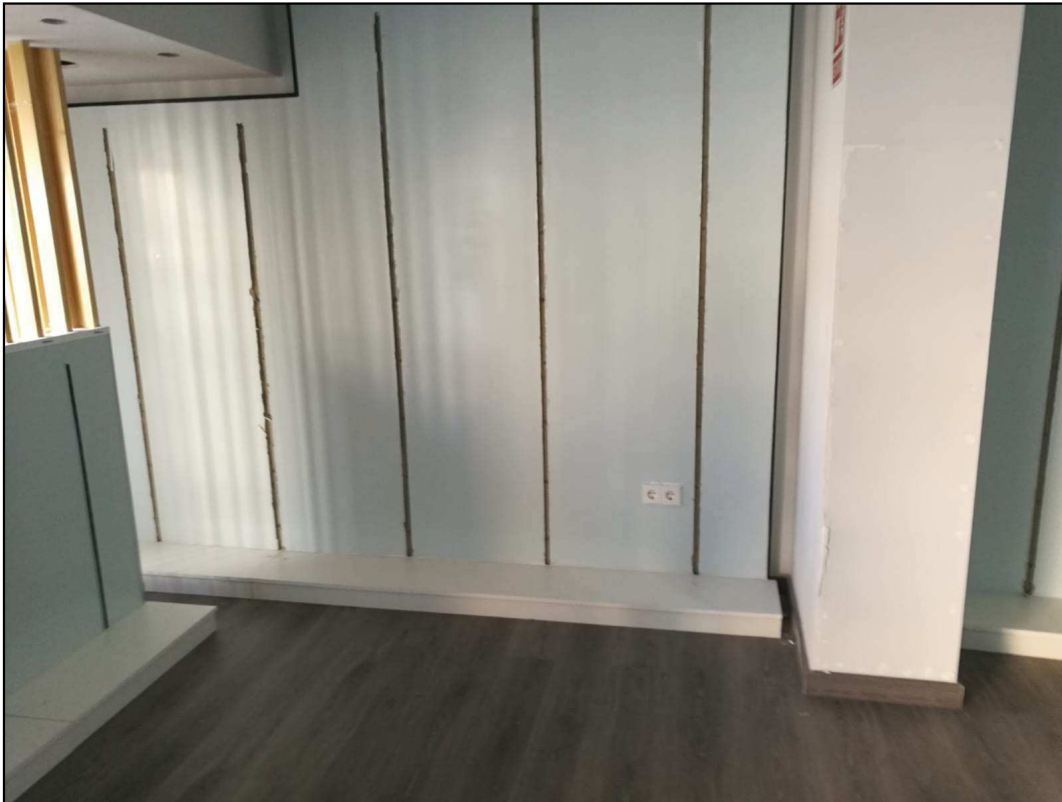
11-Vista del revestiment de fusta a retirar
